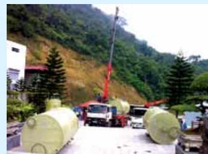
Lắp đặt Bể xử lý nước thải chế tạo sẵn cho khu Đền Thượng, Tây Thiên, Vĩnh Phúc
