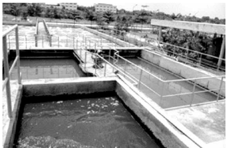
▲ Hình 3. Dung tích bể điều hòa không đủ và hệ thống keo tụ hóa chất - lắng bậc 1 làm việc kém hiệu quả là một trong những vấn đề thường gặp
