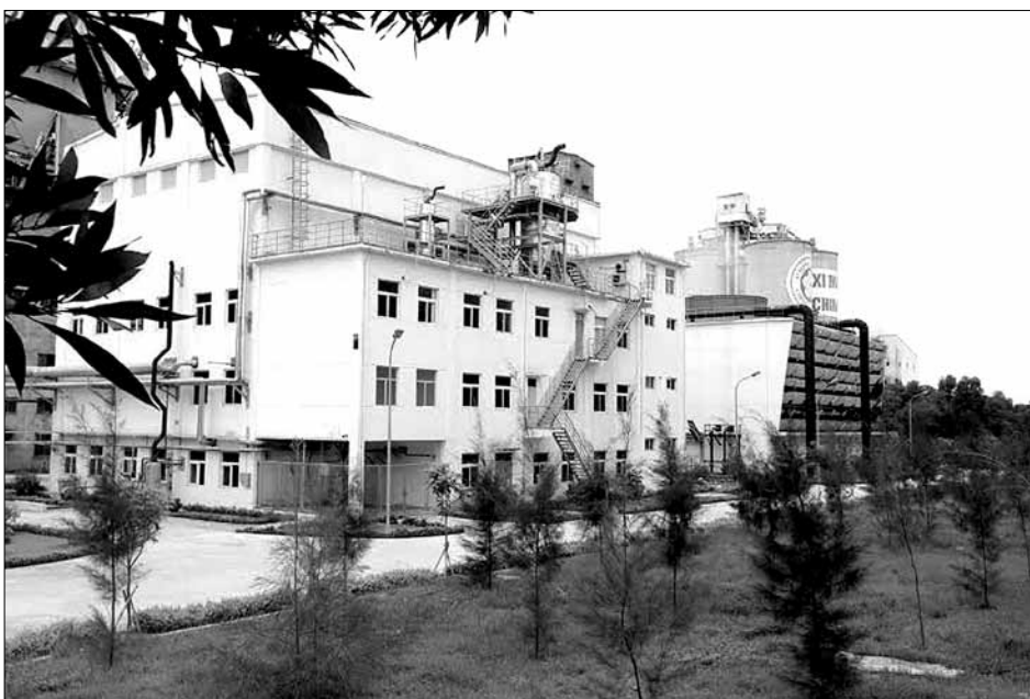
▲ Hệ thống máy phát điện nhiệt khí thải của Công ty
